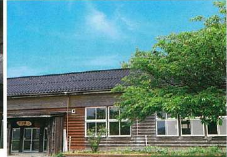
▲廃校になった西三川小学校の木造校舎は高台にあり、真野鶴を望む眺望も抜群だ。「我々の世代からすると木造校舎は懐かしい。可愛らしい校舎」と平島氏は目を細める。
