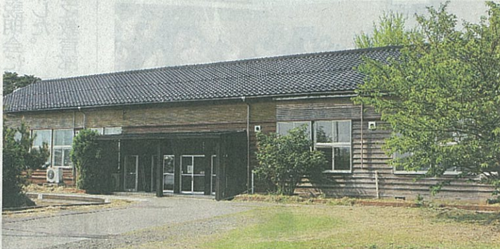
理科室などを改装し学校蔵として生まれ変わる旧西三川小学校の校舎(7日、佐渡市西三川)
